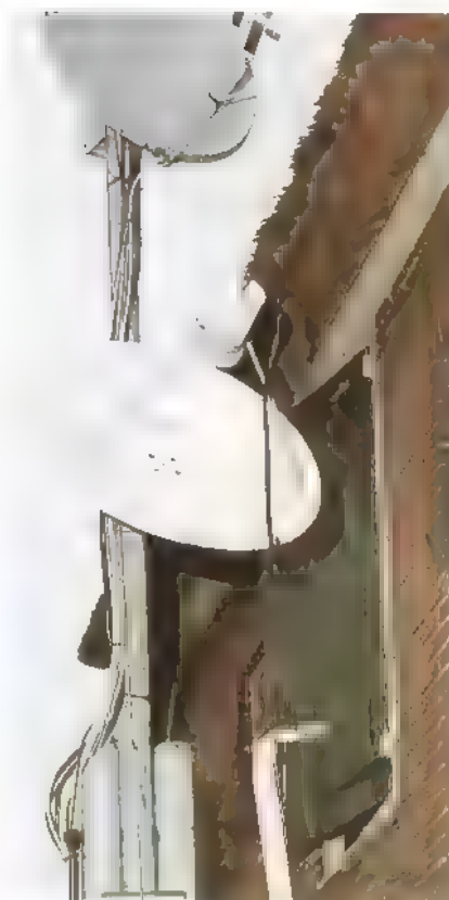
Boven: de Meteosat parabool pal zuid, 30 graden elevatie.
